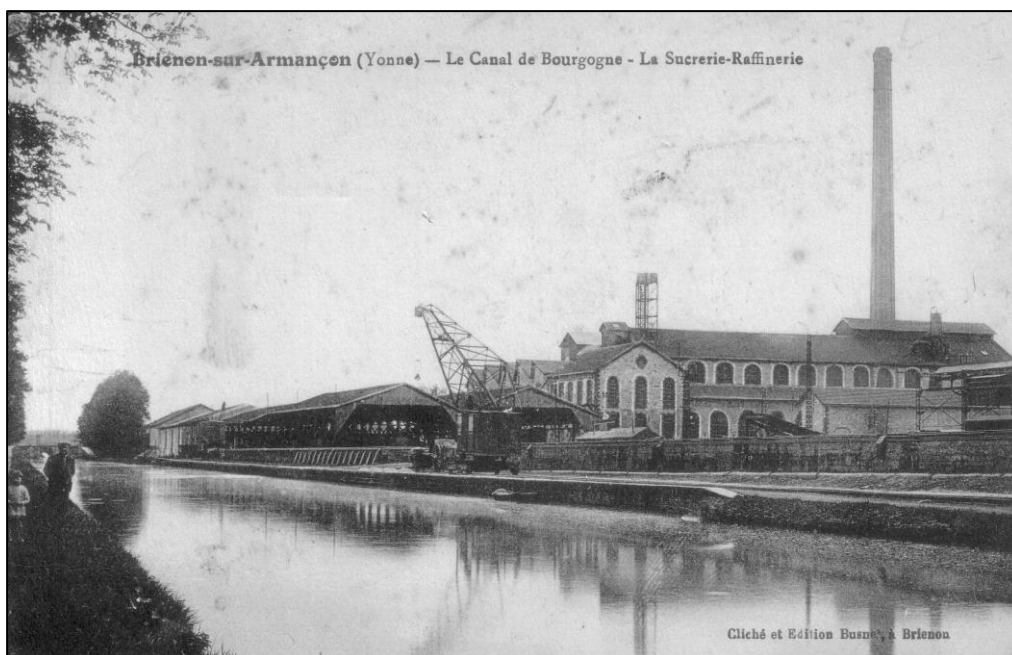
La nouvelle cheminée – La grue - CPA coll. privée
