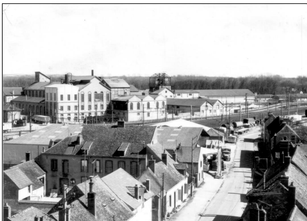
Début des années 1970, photo prise du moulin. La cheminée a été détruite
