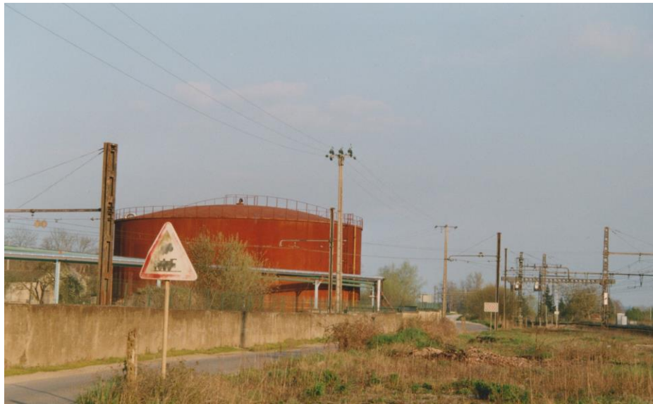
Une nouvelle cuve en 1993
