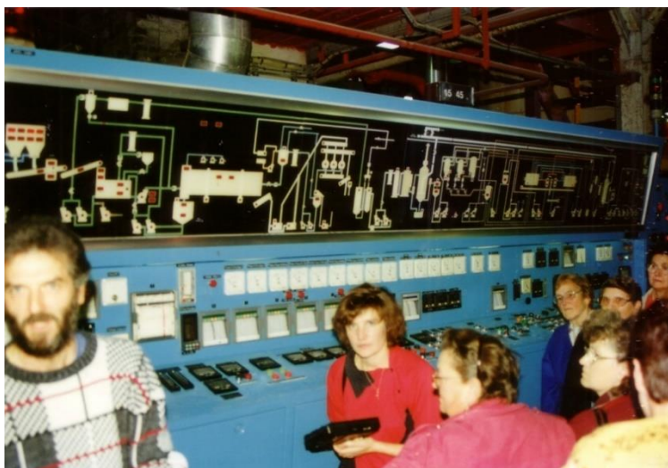
Le synoptique de la diffusion, épuration, évaporation
